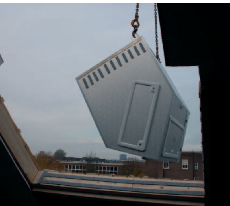
Het binnentakelen van de Hydrotop-warmtepomp.
